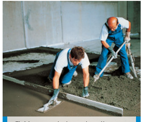
Finition par talochage du mélange Mapecem
