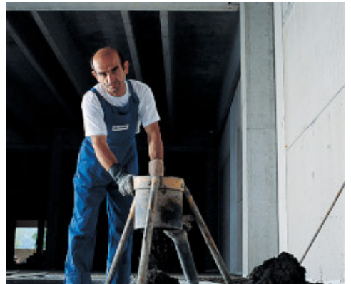
Alimentation du mélange Mapecem
