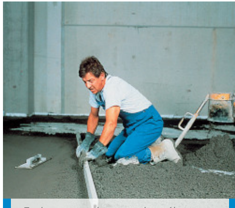
Etalage etamage du mélange Mapecem
