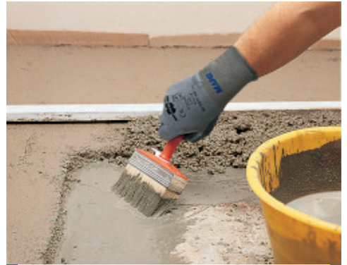
Application de la barbotine d'accrochage pour chape adhérente Mapecem
