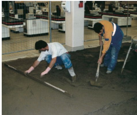
Réparation rapide d'une chape dans un supermarché
