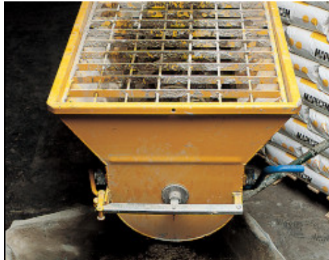
Malaxage de Mapecem avec un malaxeur horizontal
