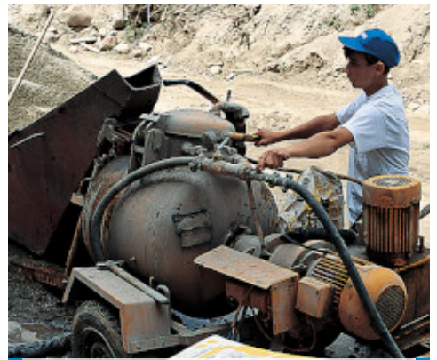
Malaxage et pompage de Mapecem avec une installation automatique
