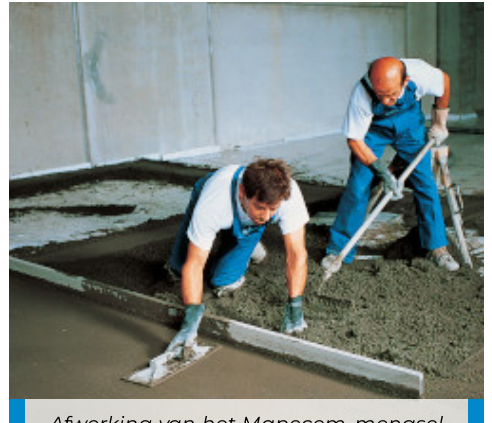
Afwerking van het Mapecem-mengsel met een strijkbord
