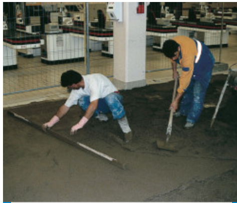
Snel herstellen van een dekvloer in een supermarkt
