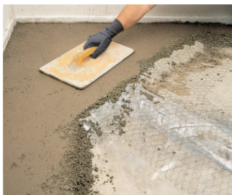
Bedekking van leidingen met Mapecem en wapeningsnet
