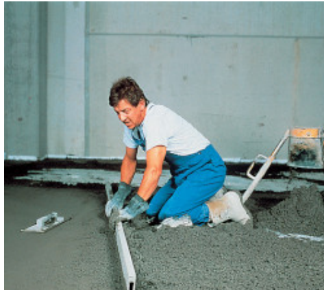
Afreien van het Mapecem-mengsel
