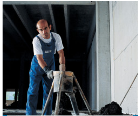
Aanbrengen van het Mapecem-mengsel
