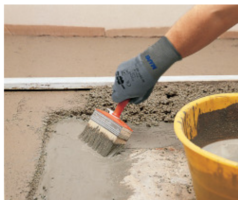
Aanbrengen van ankermortel voor aanhechtende Mapecem-dekvloeren
