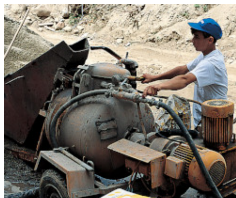
Mapecem-mengsel in een automatisch pompsysteem
