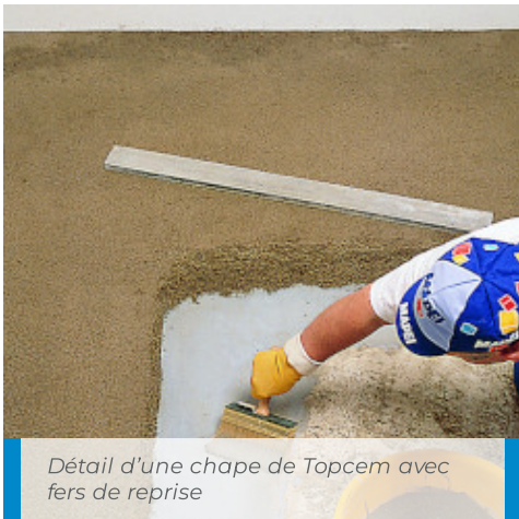
Préparation des bandes de nivellement
