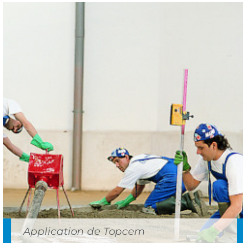
Mélange de Topcem à la pompe à pression automatique
